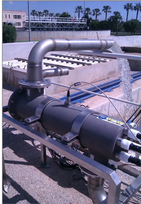
Reactor h2o.TITANIUM con disposición en línea y un caudal de agua 50 m 3 /h con funcionamiento continuo e ininterrumpido.
